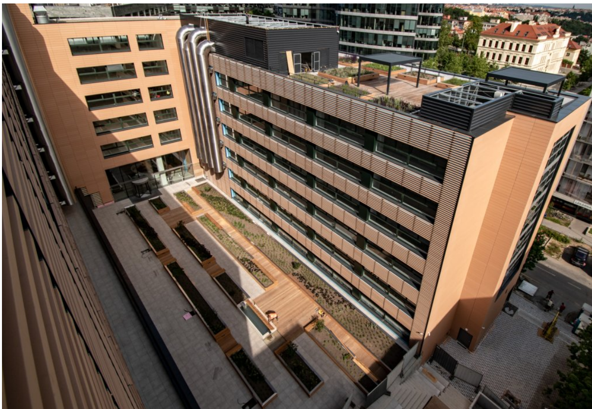
Příklad realizace terakotové fasády s nepravidelným horizontálním spárořezem (UTB Zlín)
